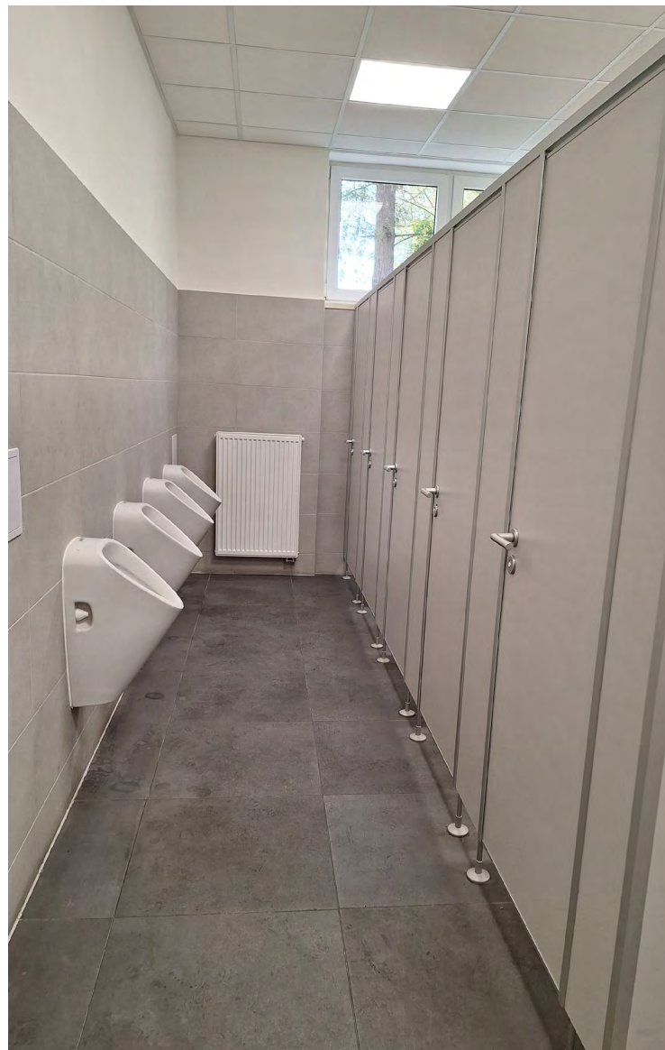
1 Rekonstrukce toalet v přízemí výrobního provozu P1
