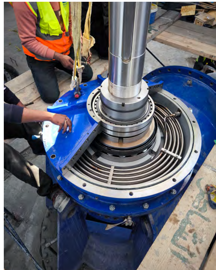
1 El Hammam PS 3 – montáž závěsu čerpadla 1400-BQBV
