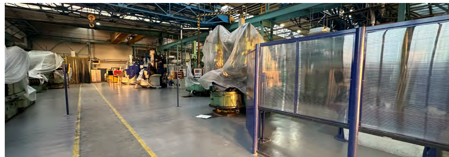
2 Karusel SKQ 20-CNC 3 Foto z průběhu realizace průmyslových podlah strojní dílna 1 a 3 loď provozu P1
