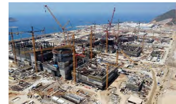
3 Průběh výstavby JE Akkuyu
